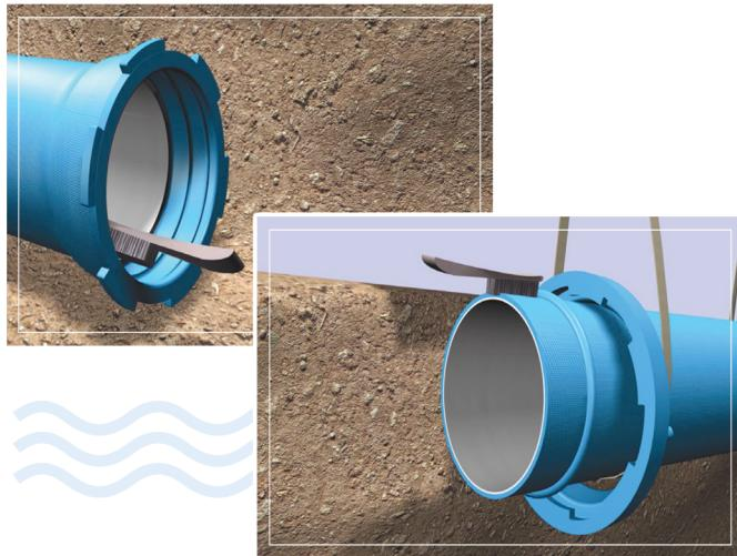
ابتدا سیم روکش دار نگهدارنده گلند که به منظور ثابت نمودن گلند به اسپیگات و حمل و نقل ایمن لوله و متعلقات استفاده شده است را از روی گلند جدا نموده و سپس با کمک برس هرگونه آلدگی و شی خارجی را از انتهای اسپیگات لوله، جداره های داخلی سرکاسه و جداره داخلی گلند زدوده و پاک نمایید.
